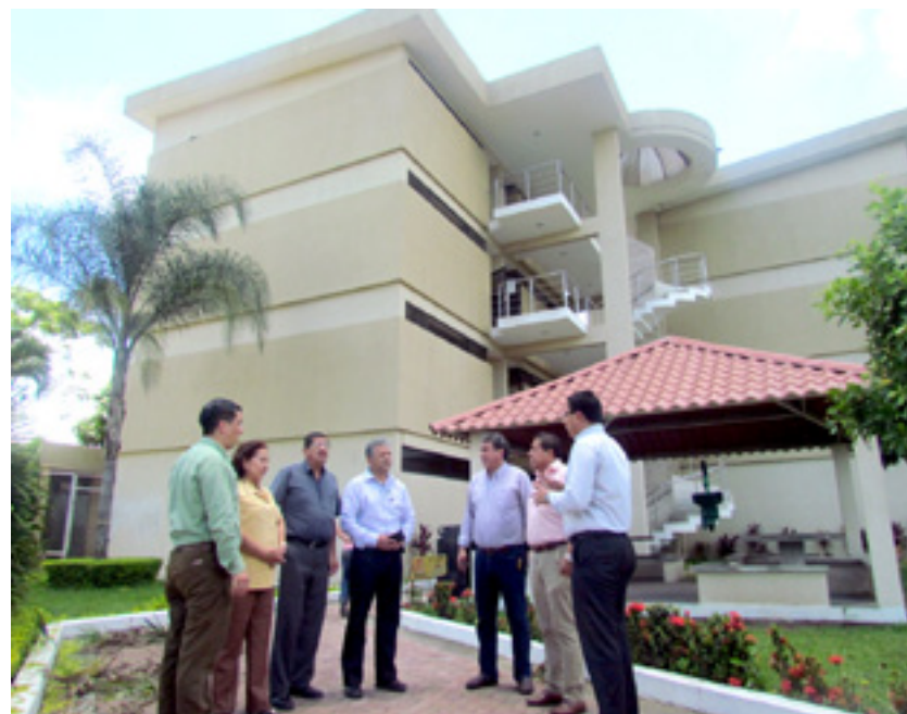
Autoridades y directivos de la UTMACH en los predios del campus Machala (Ex UTSAM). Detrás de ellos, el edificio en donde fueron renovadas las aulas y se las dotó con mobiliario nuevo.
